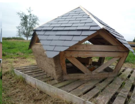
Eco-Cabane avec démonstration de mur en torchis
