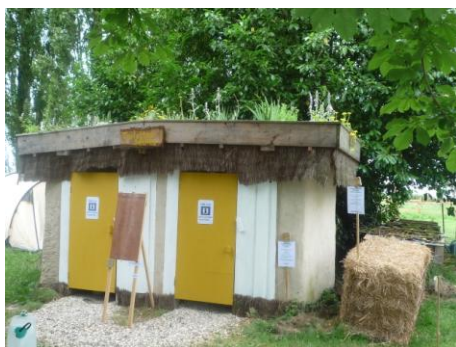
Les toilettes sèches avec toiture végétalisée
